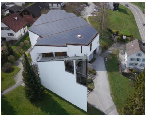
Solardach der Katholischen Kirche
